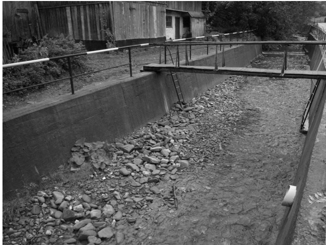
RYSUNEK 2. Odcinek uregulowany w formie bystrotoku w ujściowym odcinku potoku Jaszce (fot. A. Bucala) FIGURE 2. Regulated part by concrete wall on the estuary reach of the Jaszce stream (photo A. Bucala)
